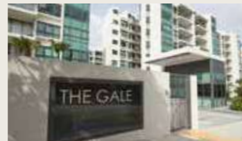
The Gale • Flora Road • 329 Units • TOP: 3 Jan 2013
